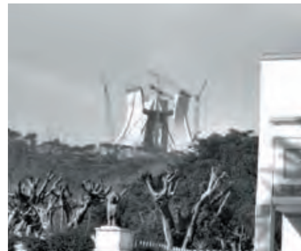
Le monument aux morts lors de sa construction.
