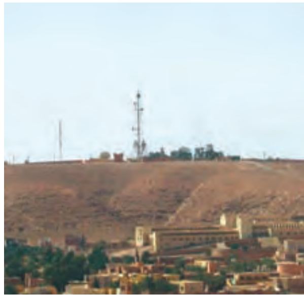
Pylône de télécommunications dans le Sud.
