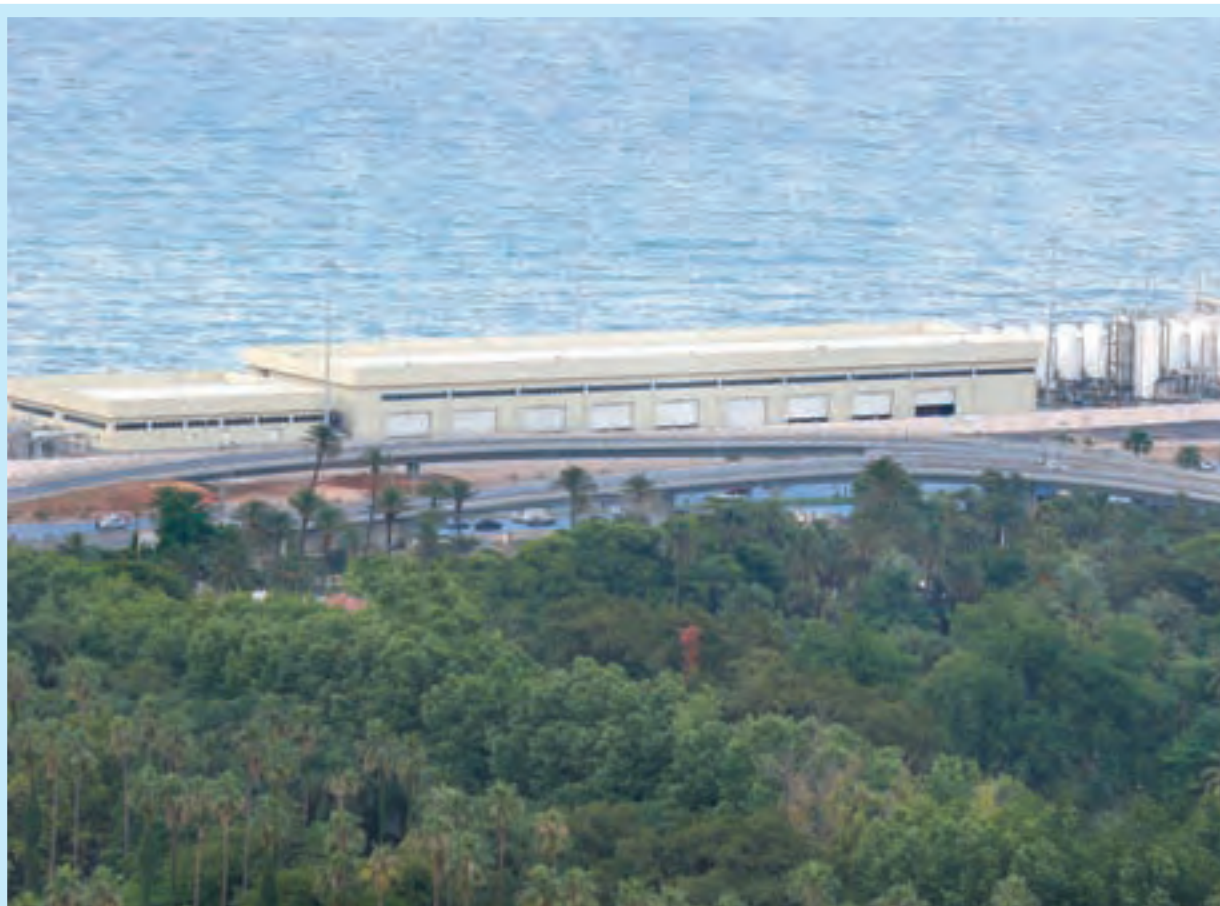
La station de dessalement du Hamma (Alger), inaugurée en janvier 2008.
