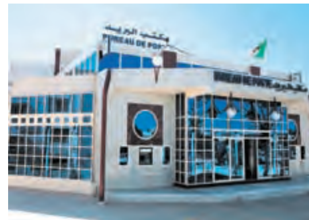
Bureau de poste d'El Eulma (Sétif).
