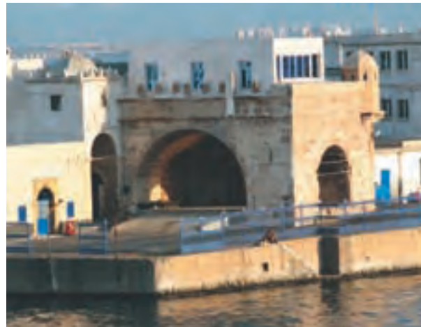
La voûte de l'Amirauté d'Alger témoigne de l'ancienneté du port.
