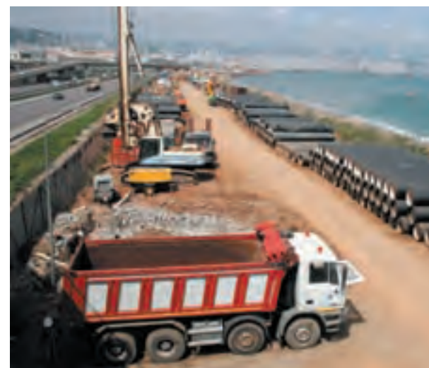
Chantier de la station de dessalement du Hamma, à Alger.
