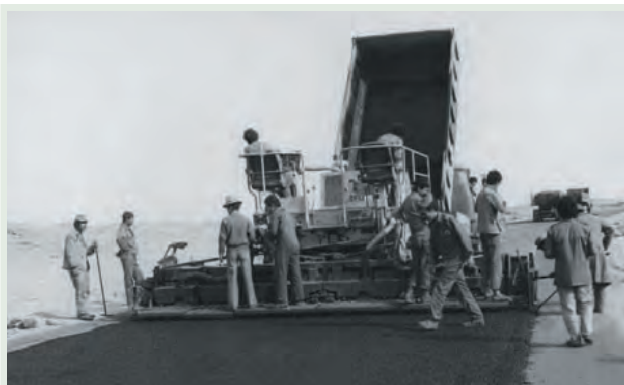
Opération de bitumage de la transsaharienne.
